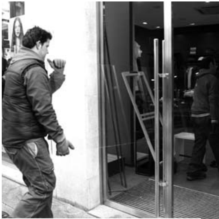
Trabajadores de una cristalería, reparando ayer los daños. J. VÁZQUEZ
